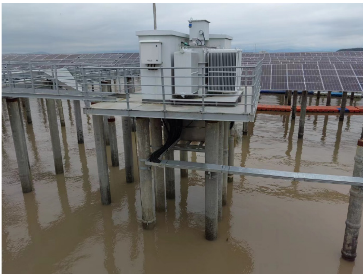
图 2.2.6 箱变平台实际布置图
