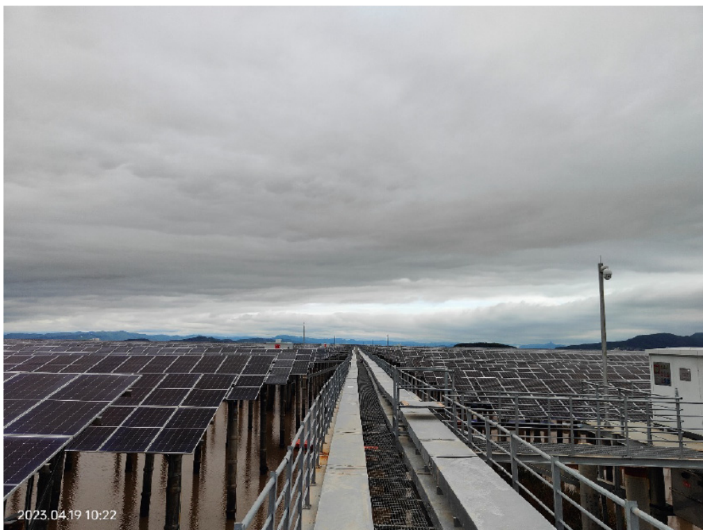
图 2.2.9 电缆栈桥实际布置图
