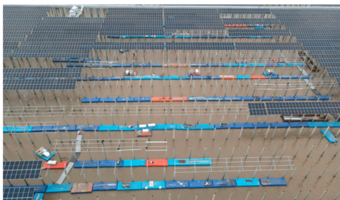
图 2.5.7 光伏组件安装
