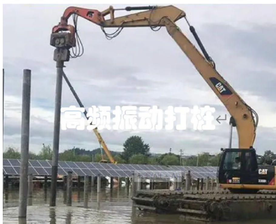
图 2.5.6 高频振动打桩机作业
