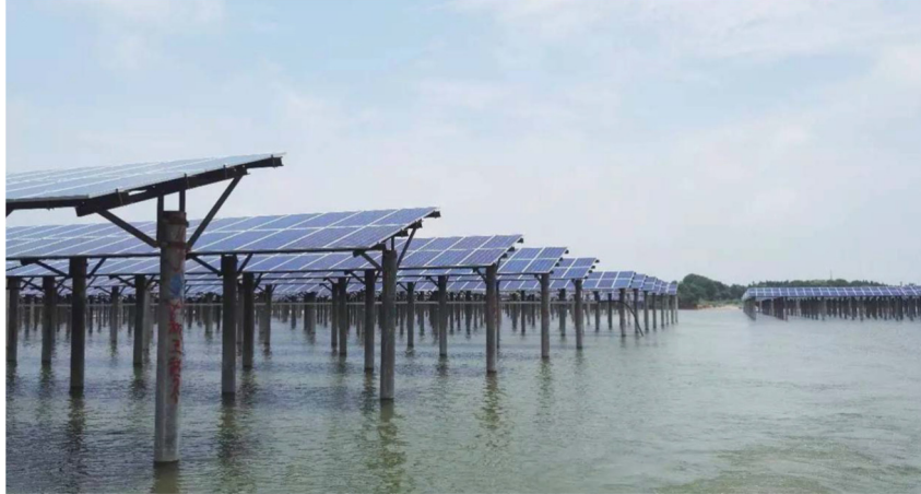
图 2.2.1 光伏组件固定式安装图
