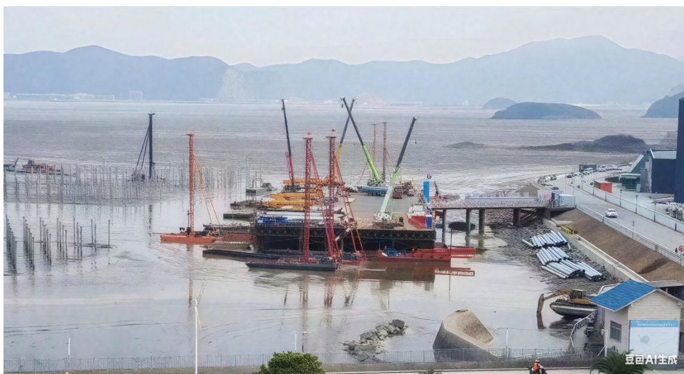
图 2.5.5a 临时出运钢平台码头实拍
