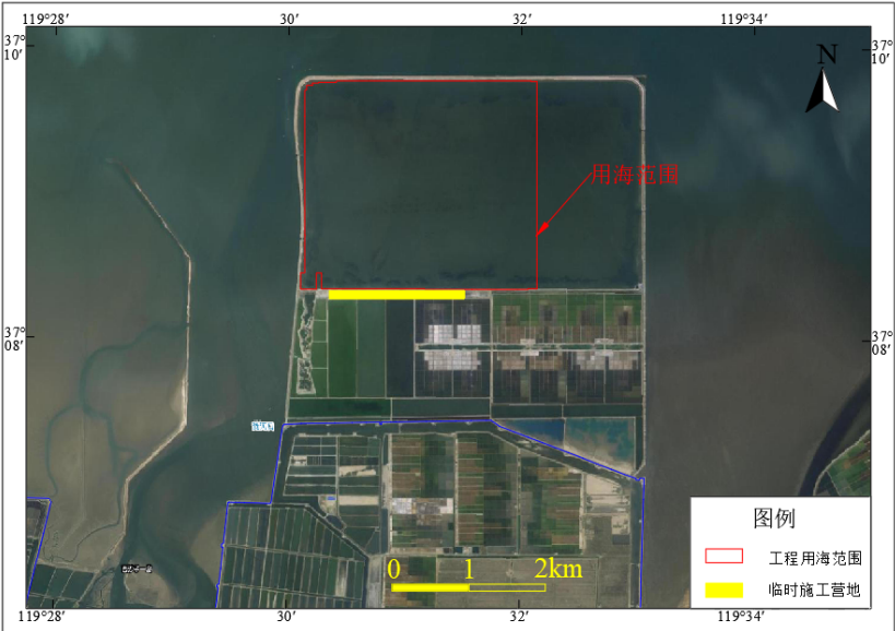
图 2.5.2 场区临时施工营地
