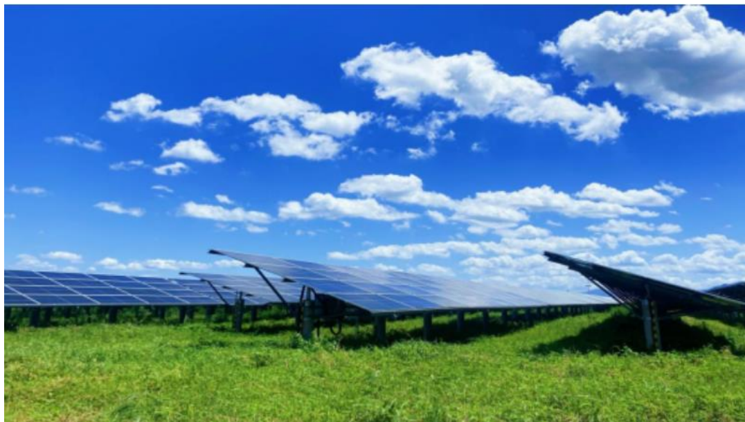
图 2-2 传统的光伏组件安装方式
