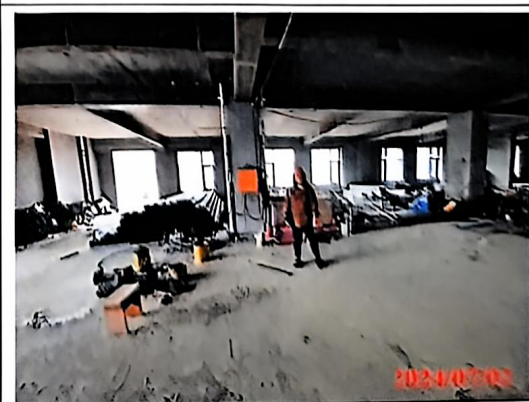
本项目拟建手术室下方2楼透析治疗区
