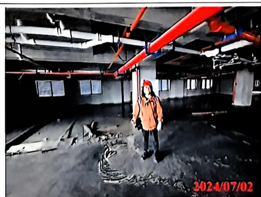
本项目拟建手术室上方4楼设备摆放区
