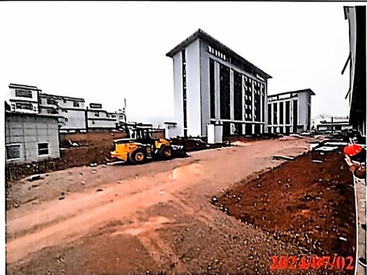
项目区南面院内道路、锅炉房、学员宿舍楼
